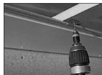
Skruva fast fästklon
