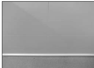
Sätt på innertakavslutningslisterna - färdig
