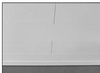
Sätt på innertakavslutningslisterna - färdig
