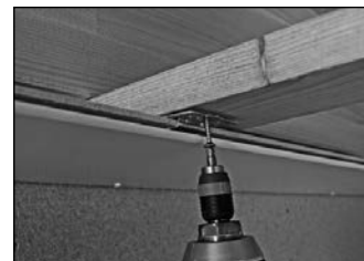
Skruva fast fästklon
