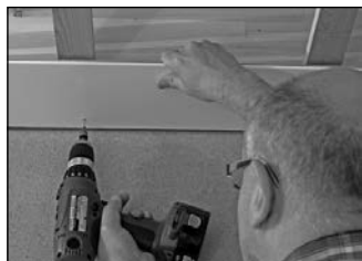
Fäst den första stick-panelen
